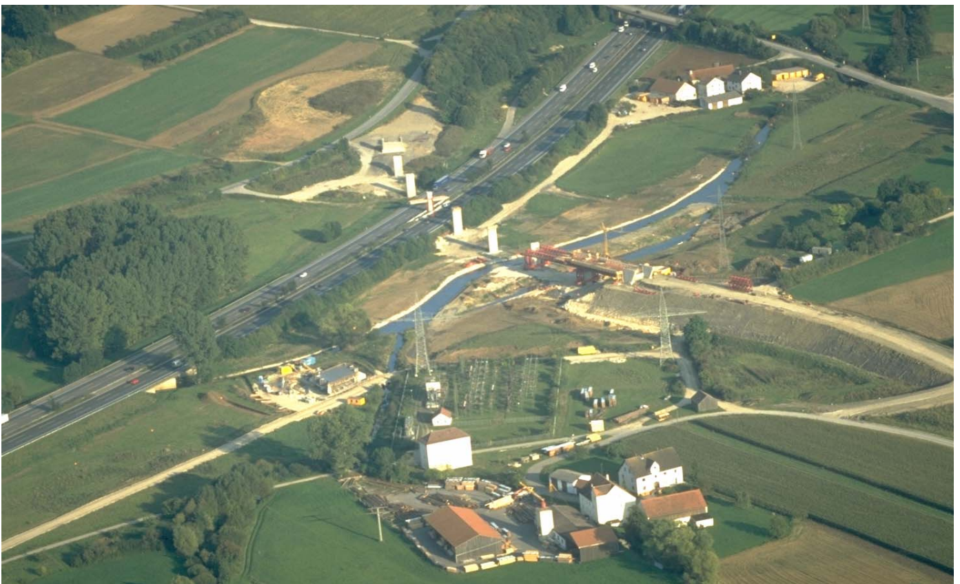
Brücke St 2227 bei Großhöbing – Blick von Nordwesten
