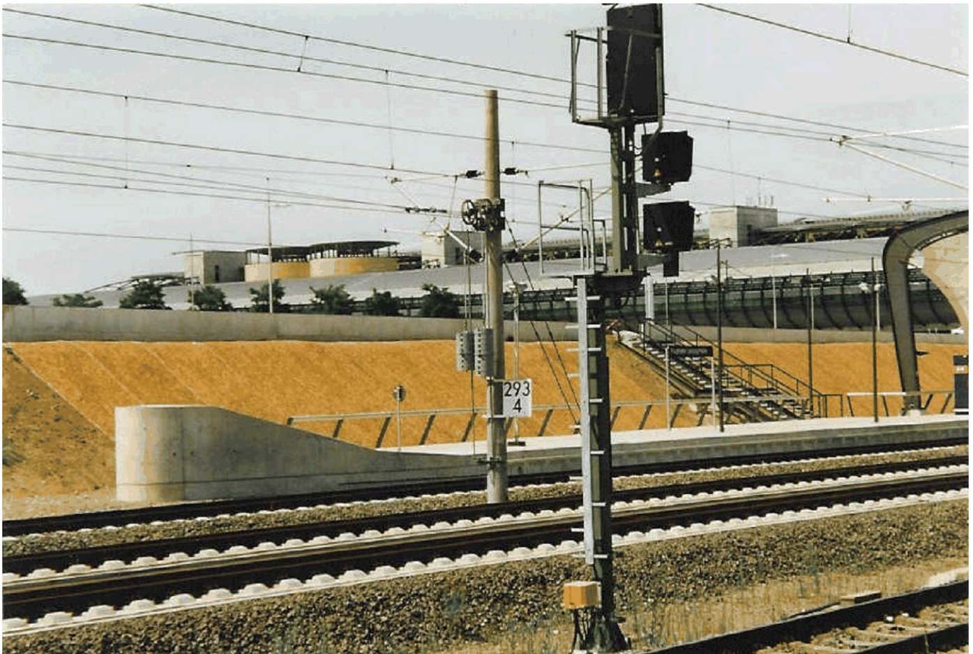
Leiteinrichtung am Bahnsteigende
