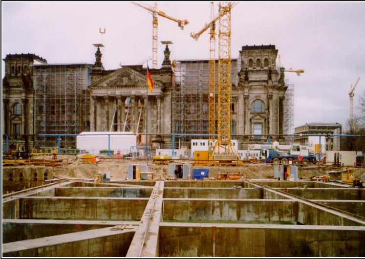
Platz der Republik, Baugrube Wand-Sohle Bauweise
